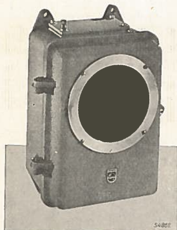
Fig. 7. De projector voor infrarood licht GM 8012.
